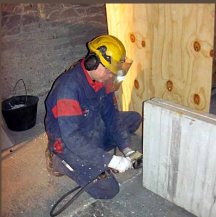
Starfsmaður Héðins notar hér réttar persónuhlífar við notkun slípirokks – hanska, andlitshlíf og heymanhlífar til viðbótar við sínar venjulegu persónuhlífar.
