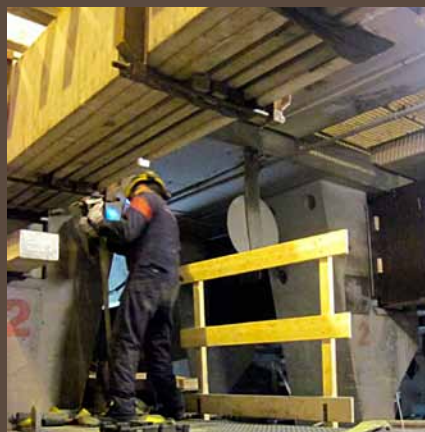
Hér hafa starfsmenn Héðins sett upp hárréttar fallvarnir meðan unnið er við straumleiðara í kerskála 2.
