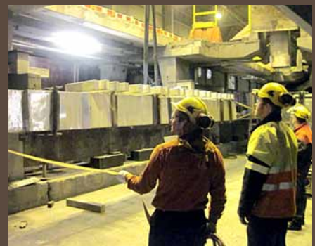
Á myndinni sést hvernig starfsmenn Héðins hafa með sér eftirlitsmann við krefjandi lyftingar á straumleiðara. Kranastjórnandinn og sá sem heldur í stýrilínuna passa sig að tala saman meðan á aðgerðinni stendur. Fyrirmyndar starfshættir!
